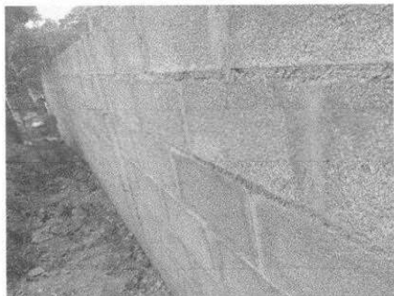
Foto 1: Se observa la parte sur del entorno educativo se finalizó la construcción del muro perimetral.
