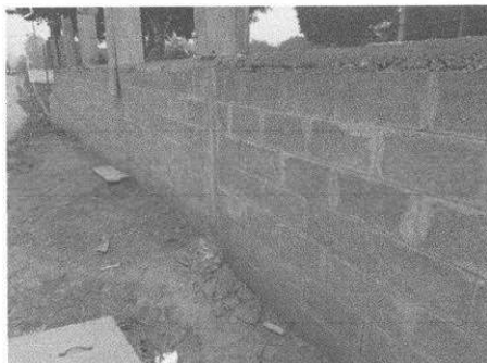
Foto 4: Se observa la parte de la calle principal ya fue finalizado el muro perimetral.
